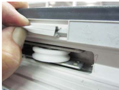
Abb.3 Einfädeln der Dichtung G032 in das Dichtteil M028
