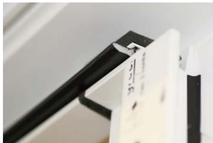
Abb. 3 Einziehen der Dichtung G045.1 bis in die Endkappe des Mittelverschlusses
