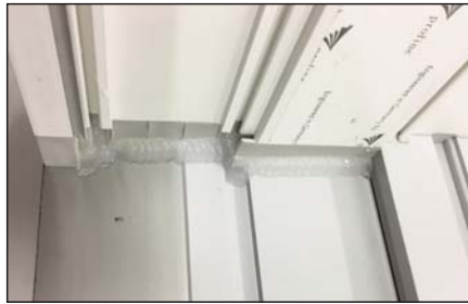
3. Dichtstoff an Zarge zur Schwelle auf der Festflügelseite auftragen
