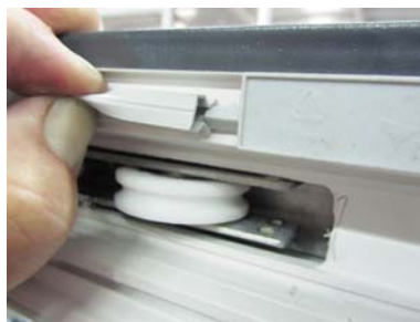
Abb.3 Einfädeln der Dichtung G032 in das Dichtteil M028
