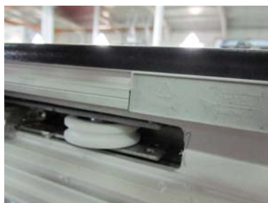
Abb.4 Endposition der Dichtung G032
