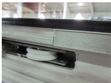
Abb.4 Endposition der Dichtung G032
