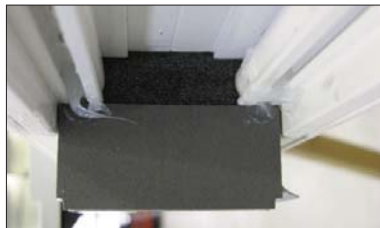
Abb. 3 Vor dem Aufbringen des Mitteldichtblocks.
