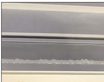
③ Dauerelastischer Kleb-/Dichtstoff auf Schwelle
