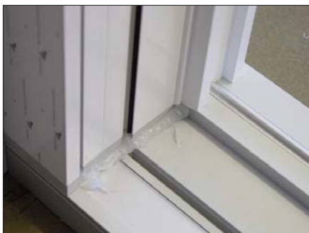
Abb. 2 Abdichtung der Schwelle mit dauerelastischem Dichtstoff
