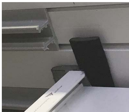
Abb. 2 M589 mittig zwischen Führungsschienen an Zarge geklebt
