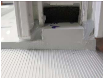
Abb. 2 Abdichtung nach der Montage des Mitteldichtblocks
