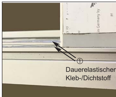
① Dauerelastischer Kleb-/Dichtstoff beidseitig in A457
