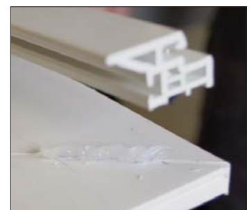
Abdichtung des Nutgrundes am Flügel vor der Montage des Mittelverschlusses
