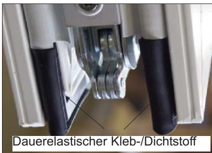
Abb. 2 Einbau Dichtteil-Set M430 , abdichten der Putzecken. Dauerelastischer Kleb-/Dichtstoff
