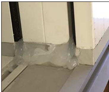
① Dauerelastischer Kleb-/Dichtstoff seitlich an Zarge Schloßseite Flügel A
