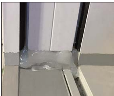
② Dauerelastischer Kleb-/Dichtstoff seitlich an Zarge Schloßseite Flügel D
