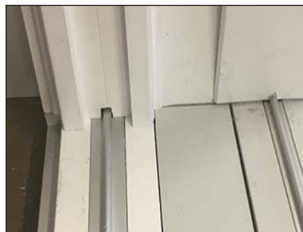
76654 auf Schloßseite Flügel D eingesetzt, Stoß mit Dichtstoff abdichten!
