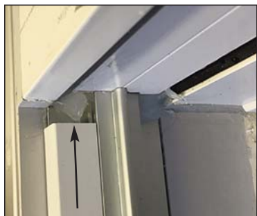
② 76662 bündig an Zarge abdichten
