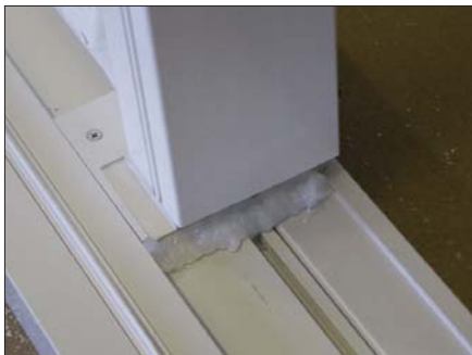
Abb. 1 Abdichtung der Schwelle mit dauerelastischem Dichtstoff
