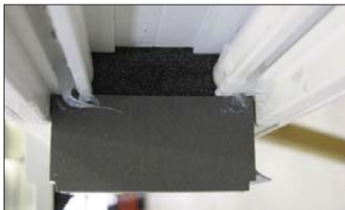
Abb. 3 Vor dem Aufbringen des Mitteldichtblocks.
