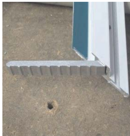
Einschieben des Eckwinkels J002
